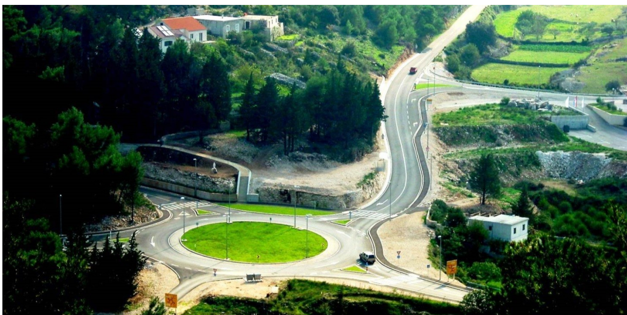
Uređeno križanje ŽC 6161 i ŽC 6193 sa izgrađenim ulazom u poslovnu zonu
